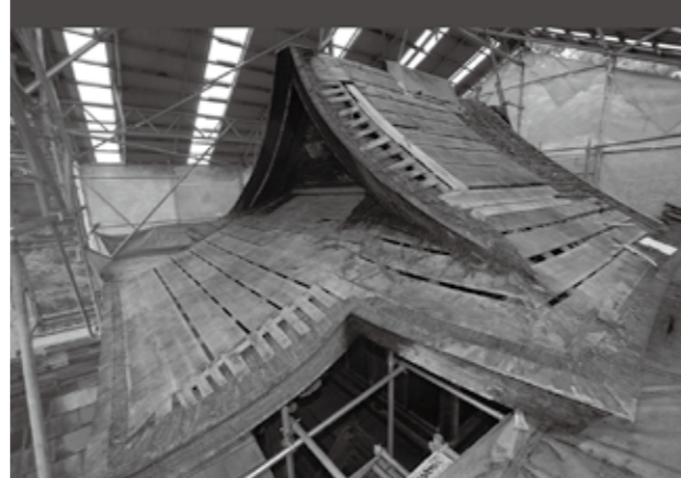
▲軽野神社(岩倉)本殿の修理工事状況(村田信夫氏提供)
