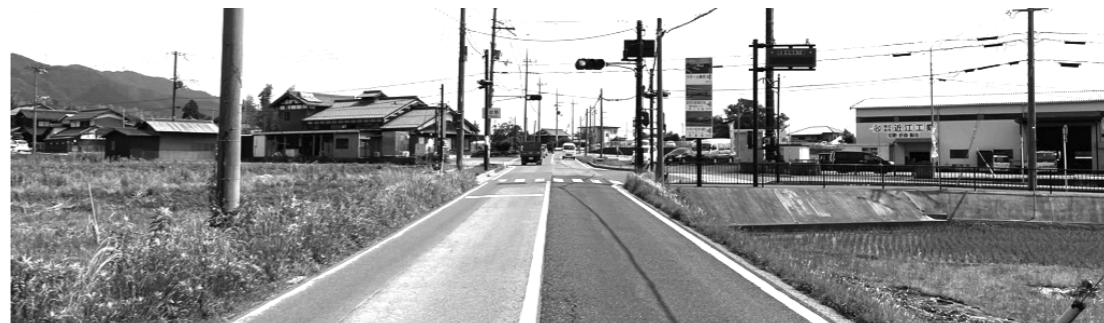
道路拡幅が予定されている国道307号線(松尾寺地先)
