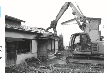
解体される空き家(参考)
