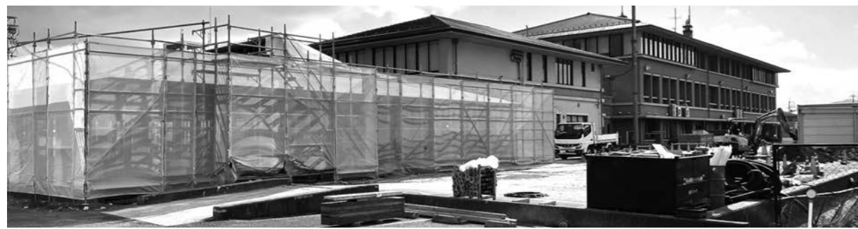
庁舎一本化により整備中の新保健センター(7月頃運用開始予定)
