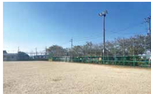
修繕された豊国運動公園フェンス
