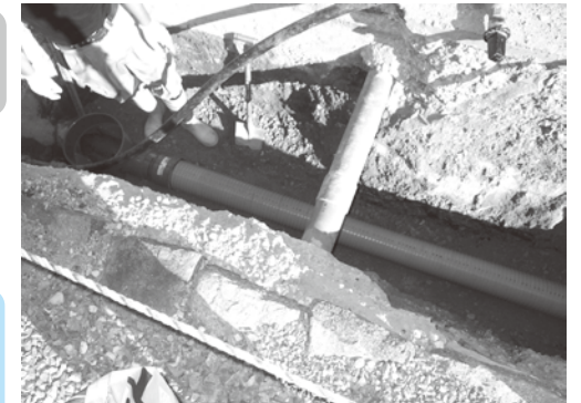
管渠埋設工事の様子
