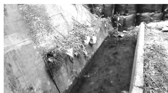
神郷彦根線の橋脚下部工事
