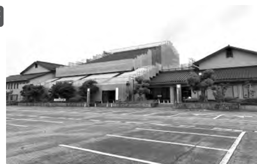
長寿命化改修工事が進むハーティーセンター秦荘
