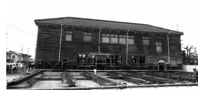
旧愛知郡役所の曳家工事(4/10)
