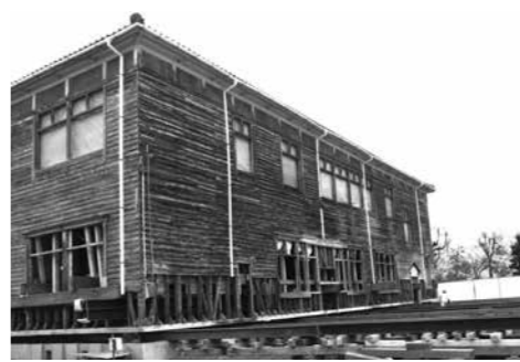
工事中の旧郡役所
