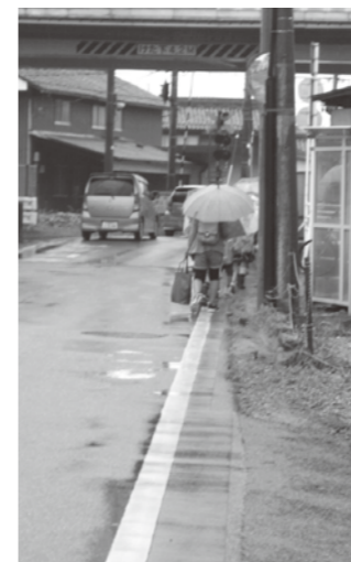
歩道が確保されていない市地先の通学路
