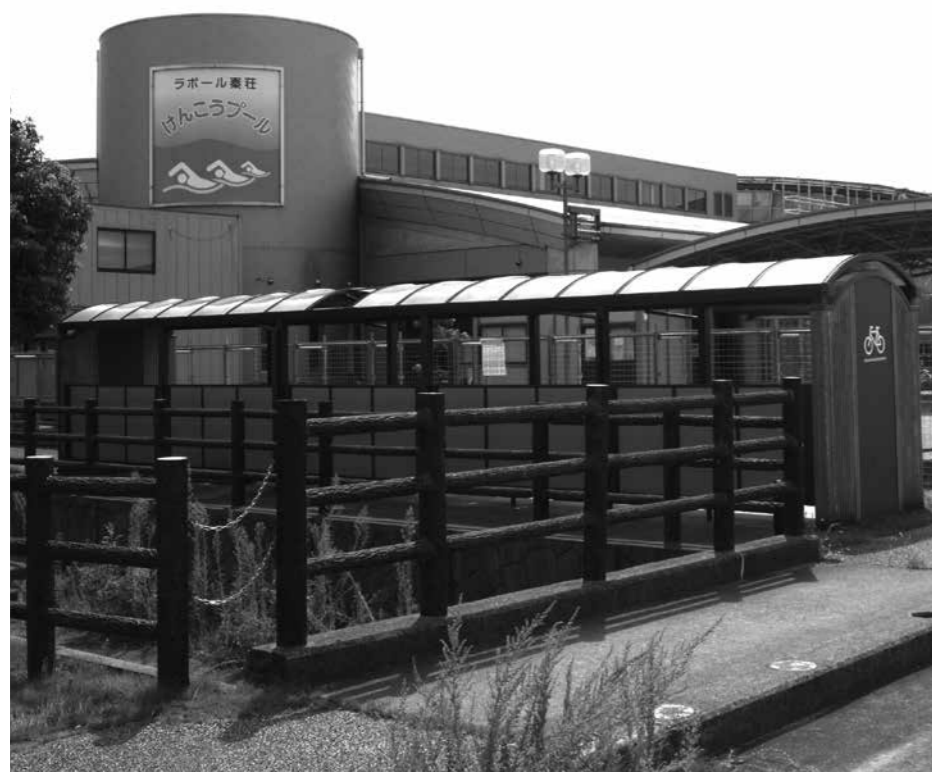
改修中のけんこうプール・来春オープン予定
