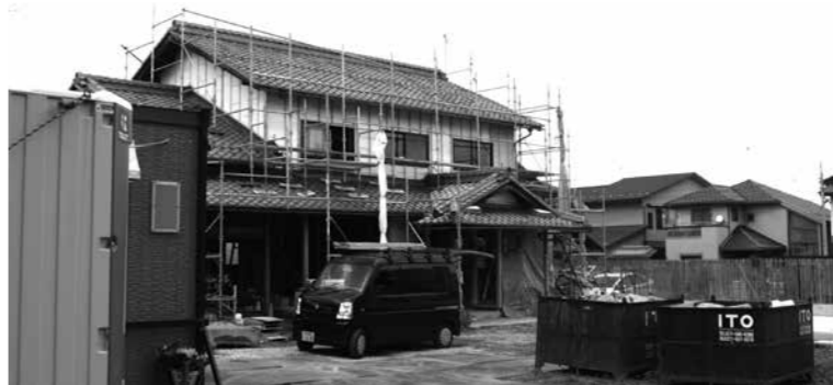
旧近江銀行裏の民家・改築中
