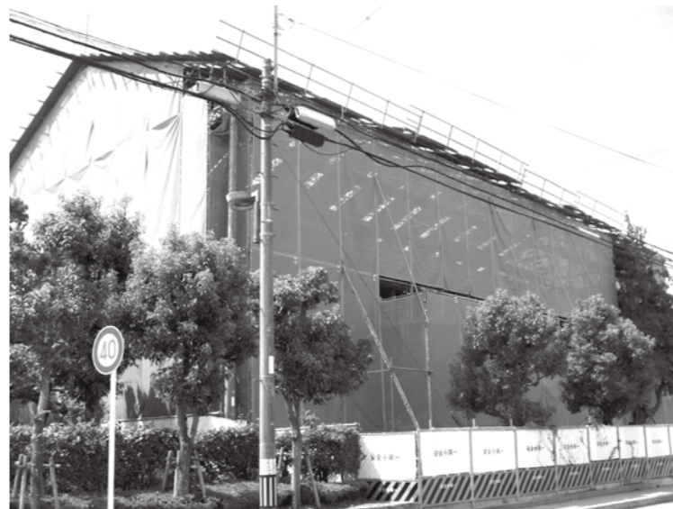
(仮称)愛荘町ふれあい交流館・ただ今工事中
