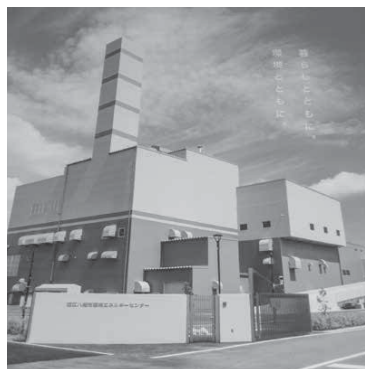
先進的な取り組みがされている近江八幡市環境エネルギーセンター(パンフレットより)
