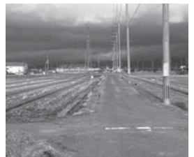
車両損傷事故が起こった道路陥没箇所
