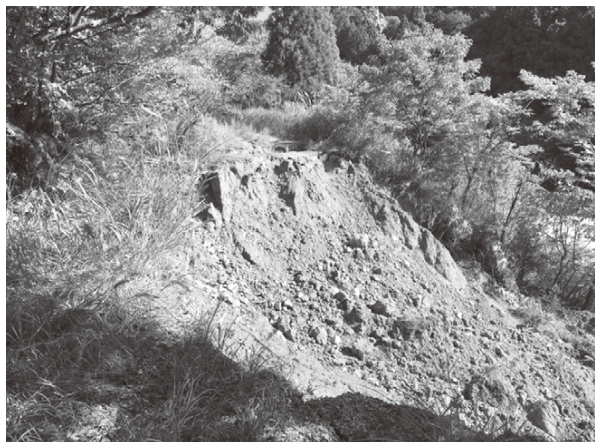
台風21号による被災現場(砂防ダム近く)
