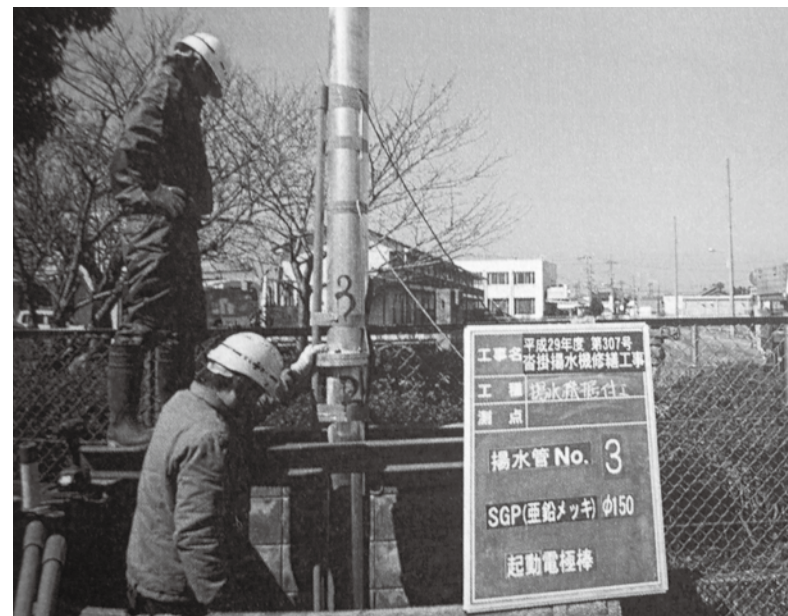
町内の揚水機修繕工事
