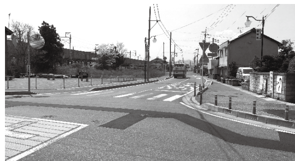
駅前の道路改良工事が進んでいる
