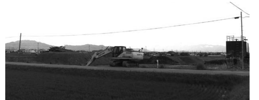
畑地に造成工事中
