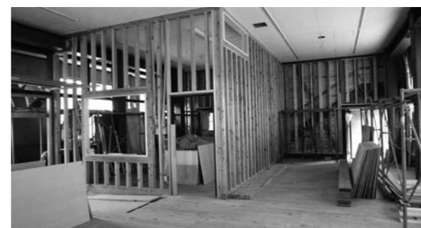
内装工事中の「ゆめまちテラスえち」
