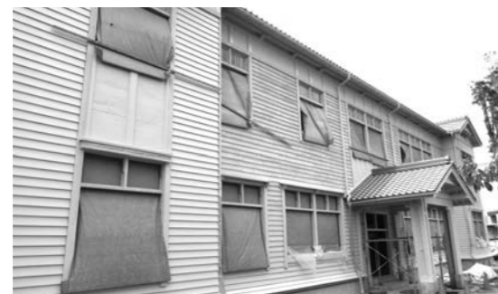
工事が進む「ゆめまちテラスえち」
