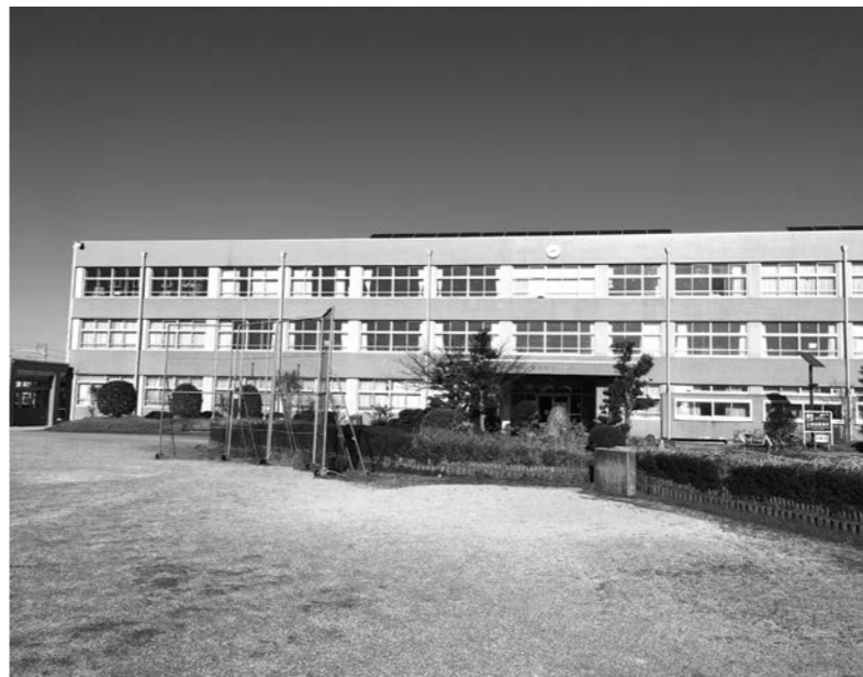
増改築が計画されている現在の愛知中学校
