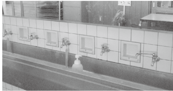
愛知川幼稚園の廊下にある水道
