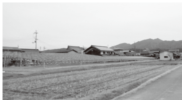
建設中の太陽光発電設備 (東出)
