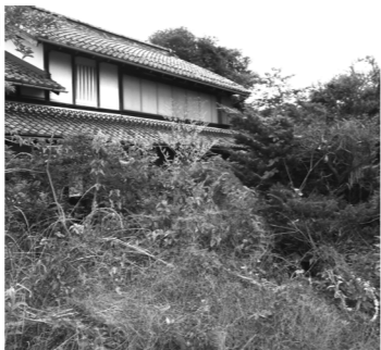
空き家の現状
