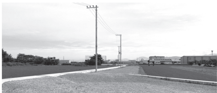
施工中の長野外周道路3号線
