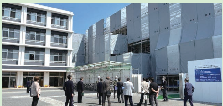
愛知中学校校舎等大規模増改築工事の進捗状況説明
