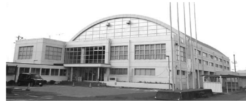
改修が待たれる秦荘体育館
