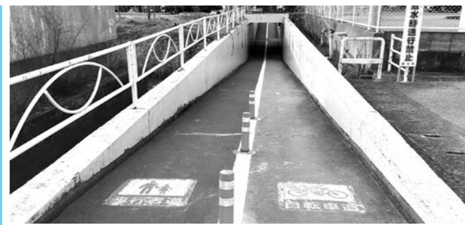
国道8号線を横断する長野地先のアンダーパス
