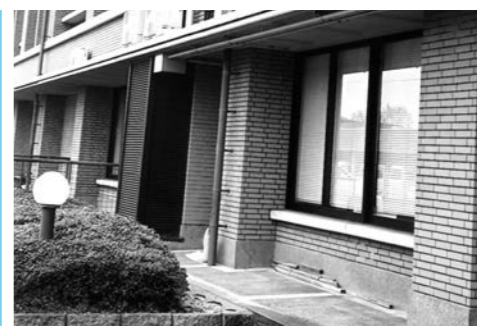
タイル張りの愛知川庁舎
