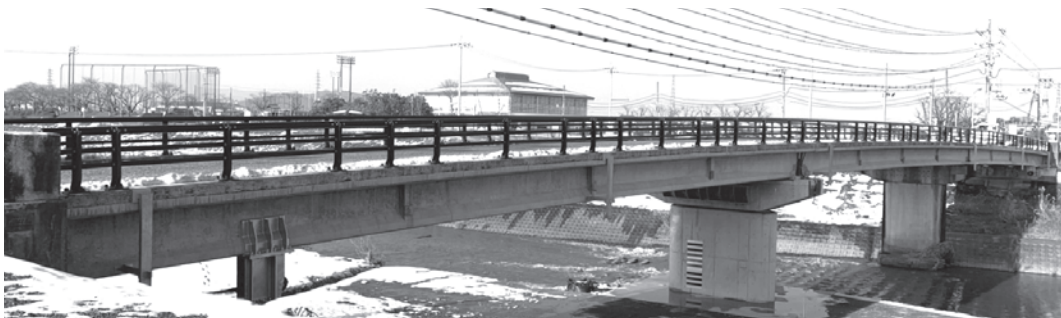
石橋地先と豊郷町を結ぶ歌詠橋
