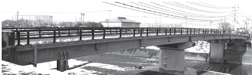
石橋地先と豊郷町を結ぶ歌詰橋
