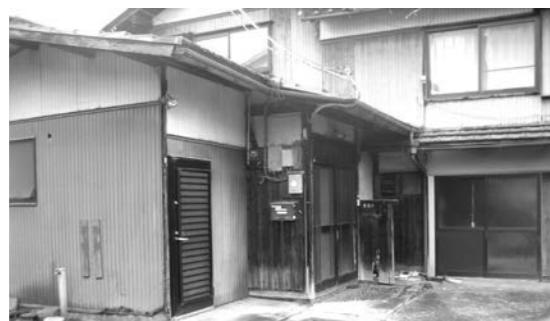
築60年の空き家
