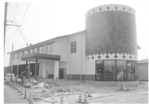
山川原地域総合センター (工事中)
