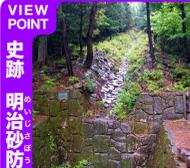
宇曾川流路工。秦川山は急峻で浸食されやすいため、明治44～大正元年に施工。全長135m(枝線込み196m)、自然石を丁寧に敷き並べた幅5mの母体。百年近くも形状を保っている近代の産業文化財。2001年登録有形文化財に指定。
