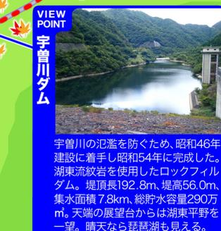
宇曾川の氾濫を防ぐため、昭和46年建設に着手し昭和54年に完成した。湖東流紋岩を使用したロックフィルダム。堤頂長192.8m、堤高56.0m、集水面積7.8km<sup>2</sup>、総貯水容量290万m<sup>3</sup>。天端の展望台からは湖東平野を一望。晴天なら琵琶湖も見える。
