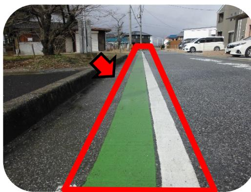
※ 歩行空間の確保および通行車両への注意喚起のために路側帯を設置・カラー化（グリーンベルト）
