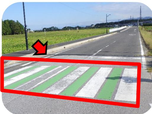
※ 交通量が多く、横断する歩行者が多い箇所に横断歩道を設置。また、ドライバーにさらなる注意喚起を促すために横断歩道をカラー化
