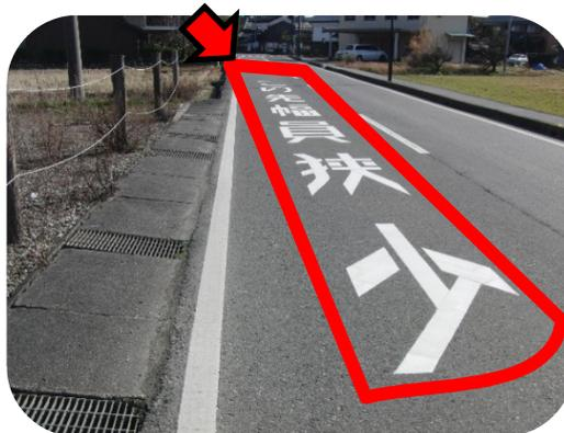
※ ドライバーに速度抑制や慎重な運転を促すために、注意すべき状況を予告する路面標示を設置
