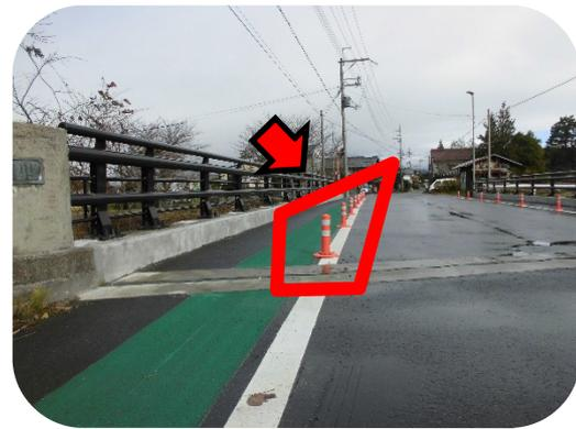
※ ドライバーに車道幅員を狭く見せることによる速度抑制や、歩車道を分離することによる歩行者通行の安全性の向上を目的に外側線にポストコーンを設置
