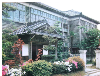
昭和50年頃の西側の校舎(特別教室棟)
