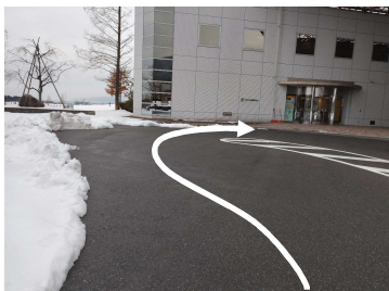
ロータリー。 バスは玄関前まで進入し、ロータリーにて転回を行う。 ※撮影日が雪であったため、ロータリーの一部が雪で隠れているが、道路幅の広さは十分にある。
