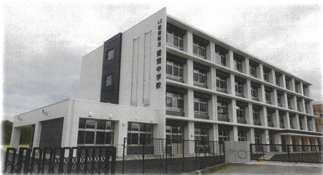
(普通教室棟完成写真)
