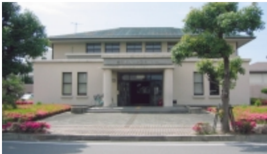
愛荘町立 愛知川保健センター
